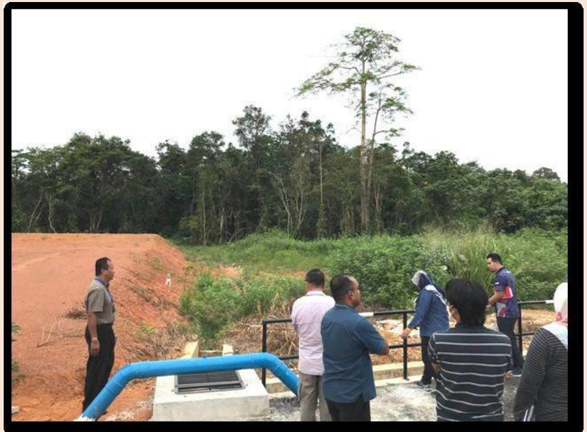
Lawatan Tapak Aduan Banjir Kilat Taman Jengka Indah
